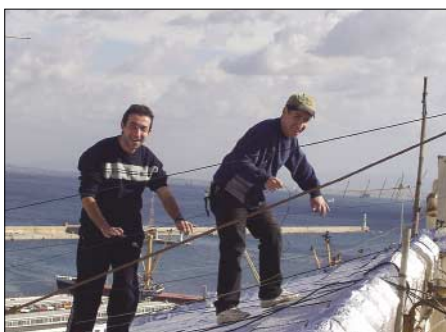
Afif und Faouzi bei den Antennenarbeiten
