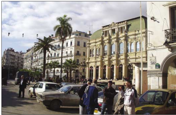
Das Gebäude (links), in dem die algerische Amateurfunkorganisation „Amateurs Radio Algériens (ARA)“ untergebracht ist. Rechts die Oper von Algier.
