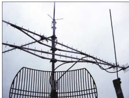
Antennen von DB0BOH (Bocholtz). Ganz oben eine Einstiegsantenne, darunter drei Yagis für die 23-cm-Links.
