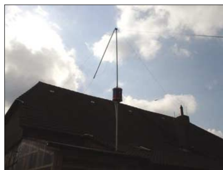
Die durch den Sturm am 21.3.2004 abgeknickte Langwellenantenne von DK8KW
